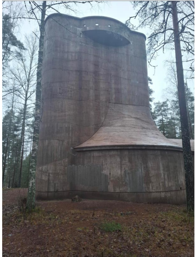
Rajamäen tykkitornin kunnostettua julkisivua
